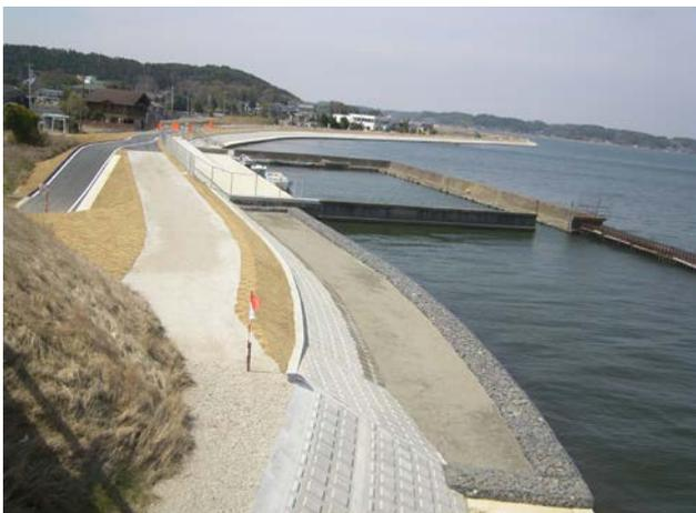
◆完成(堤防補修工および根固め工)
